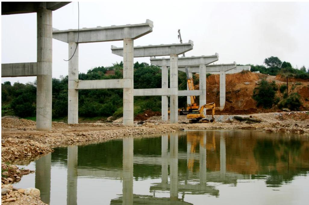
即将吊装最后 5 跨桥梁构件
