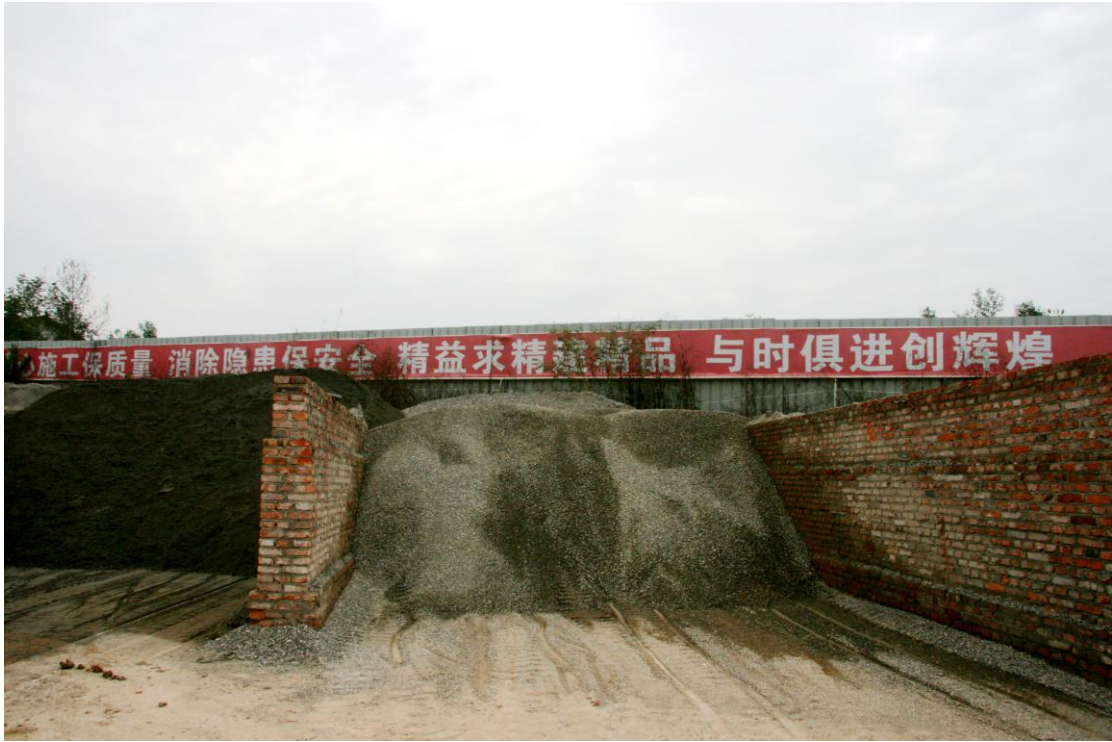
砂石材料堆放区
