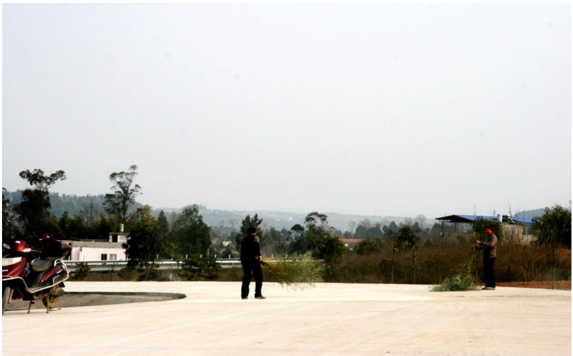
工人正在清扫已经铺通的匝道路面
