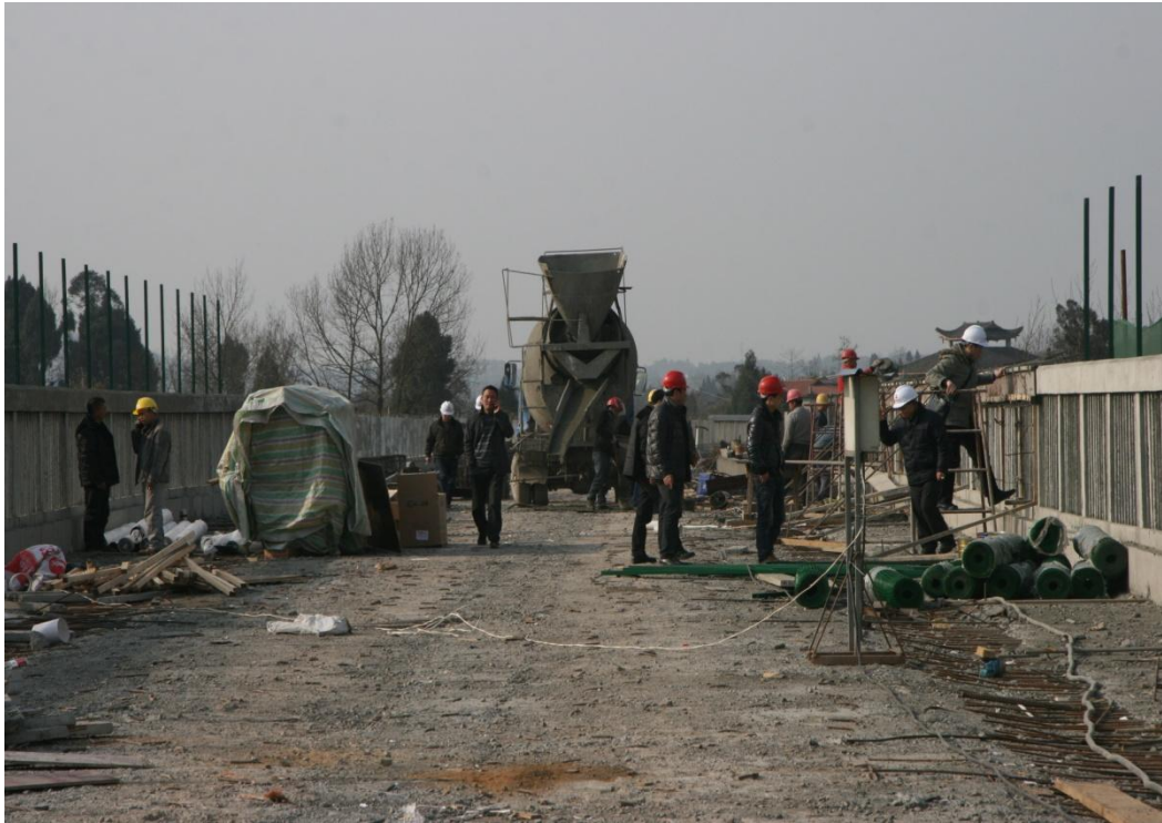
检查组的人员分项检查
