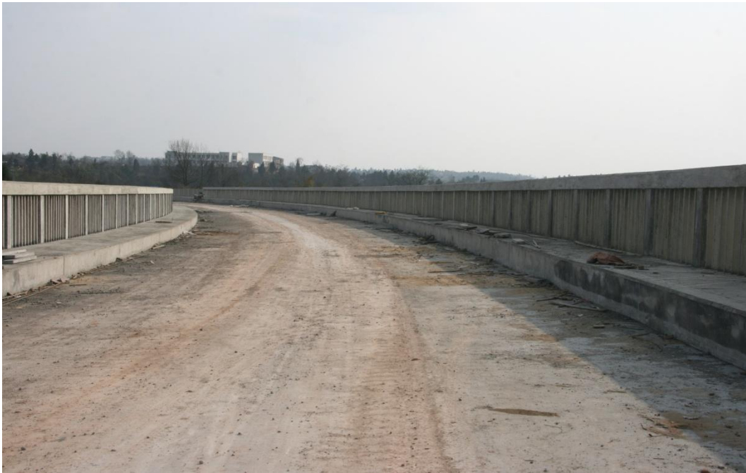
绵广高速跨线桥已经架通
