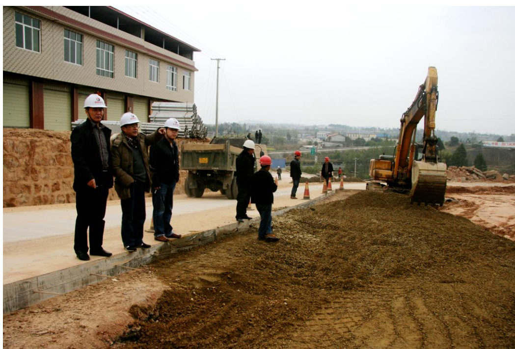
铺设剩余的半幅连接贯山镇街道的路面
