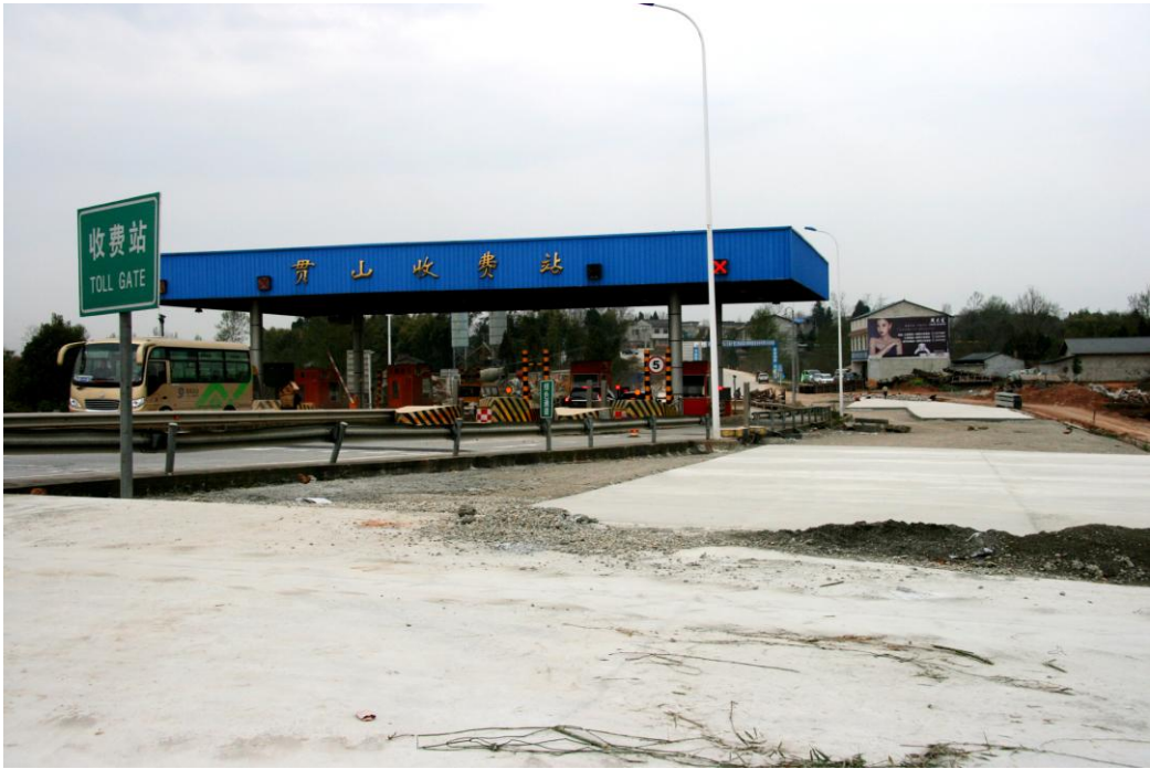
预留收费站路面，待收费站建好后再铺设
