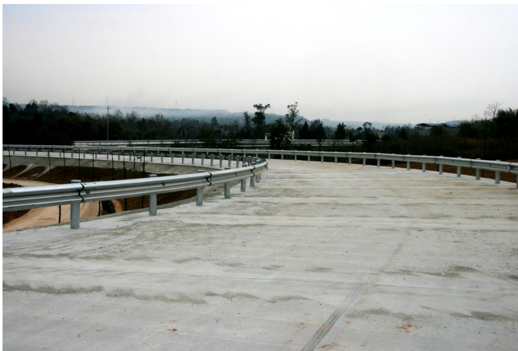
已经完工的两条匝道
