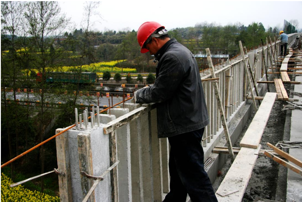
工人师傅在绑扎护栏钢筋
