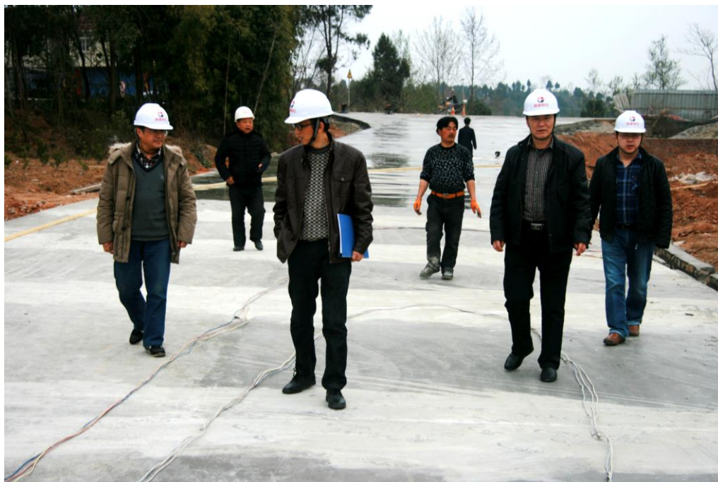
认真检查铺好的路面
