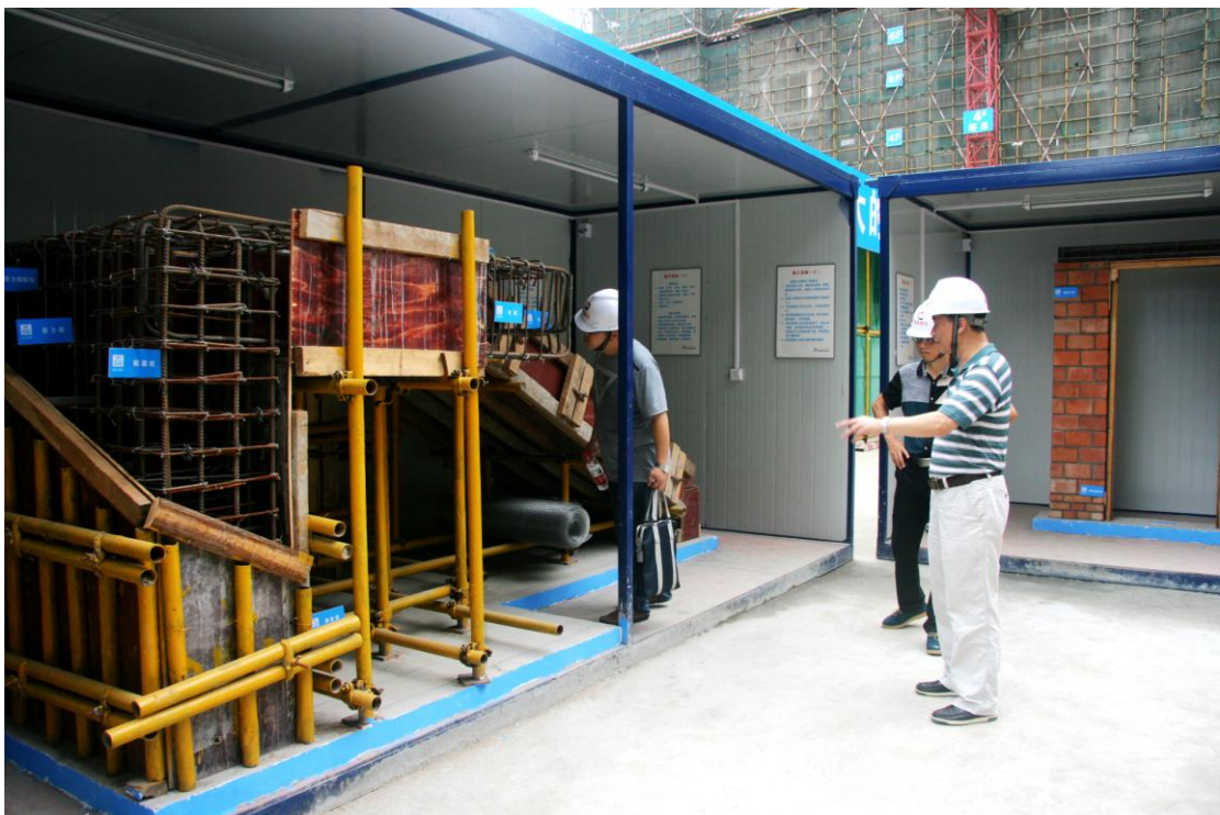
工地现场模型样板
