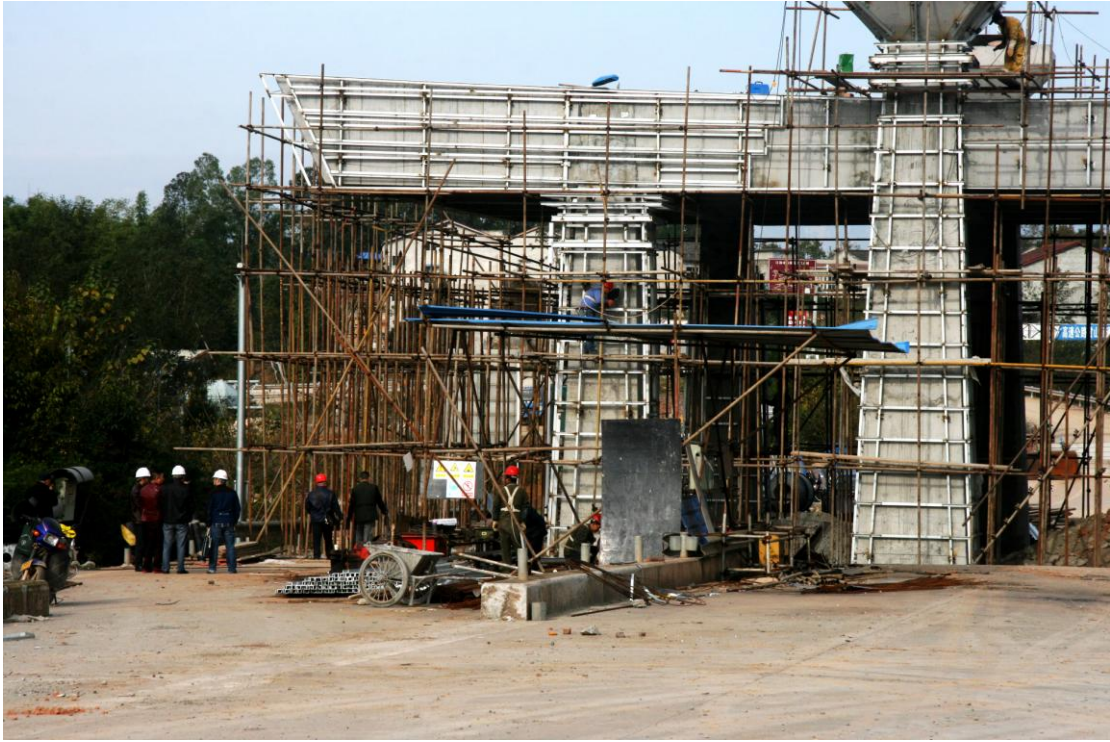
施工现场一角
