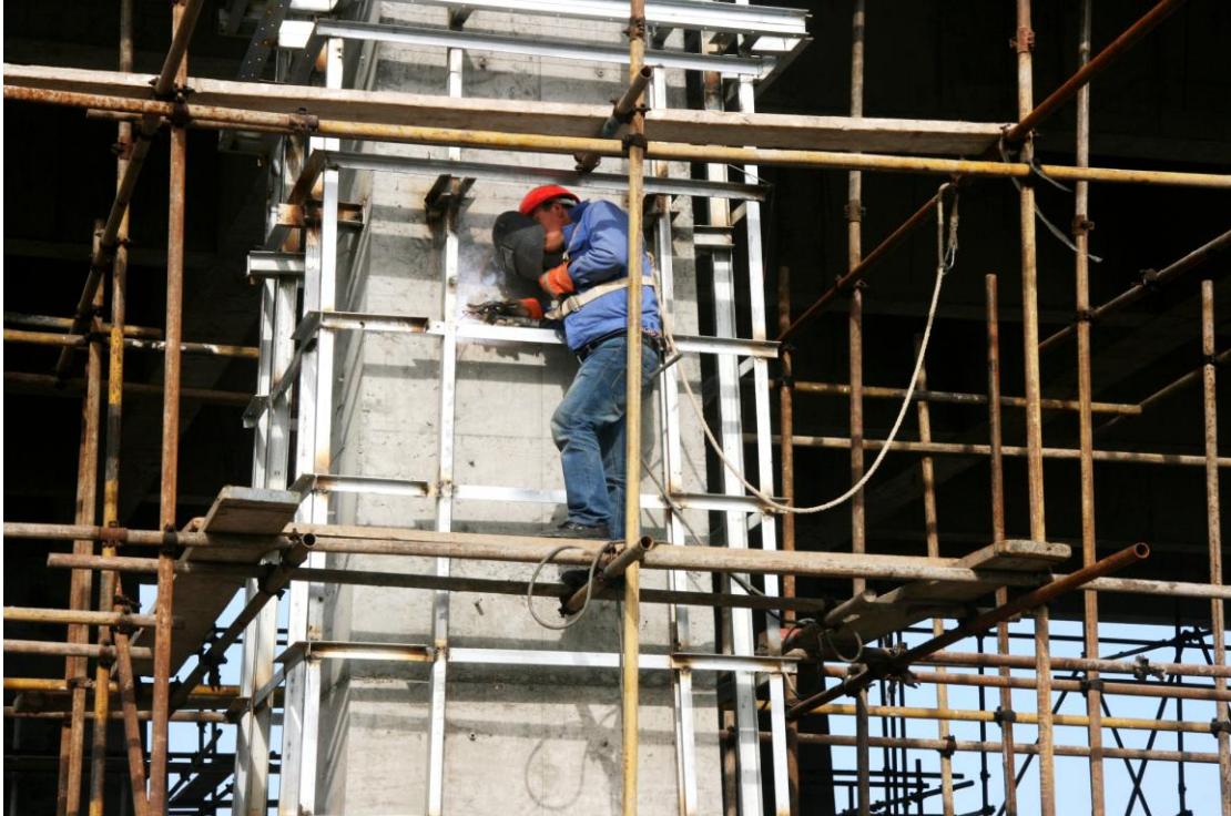
工人高空焊接作业
