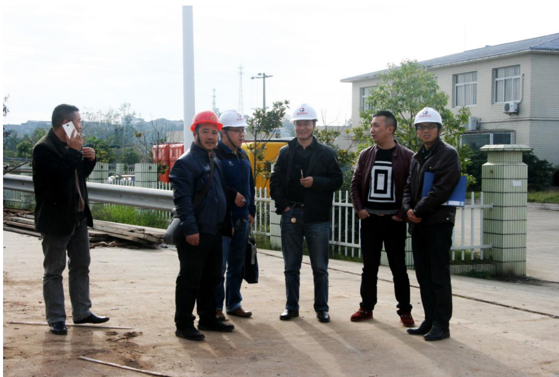
施工现场检查评价
