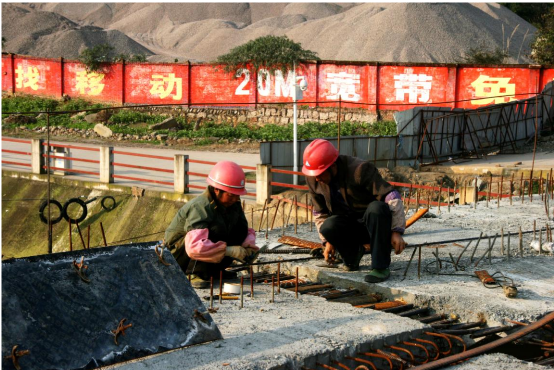
工人正在精心施工
