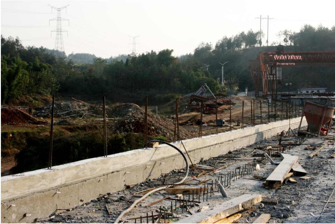
开始护栏施工
